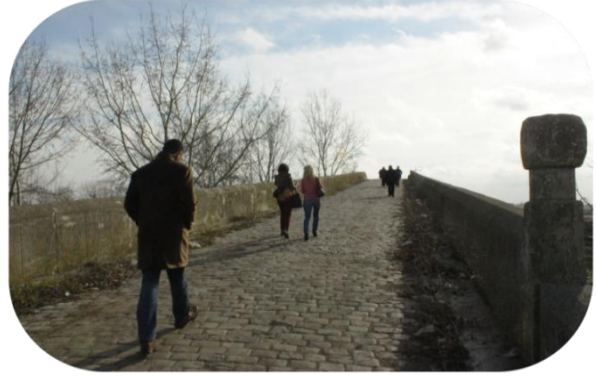
Sokullu Mehmet Paşa "Sinanlı" Köprüsü
