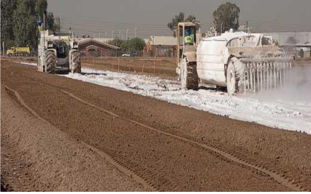
Şekil 2.1 : Kirecin yol yapımında uygulanması
