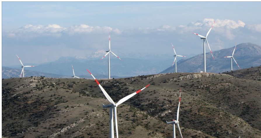
Şekil 2.11: Rüzgar enerji santrali [52]
