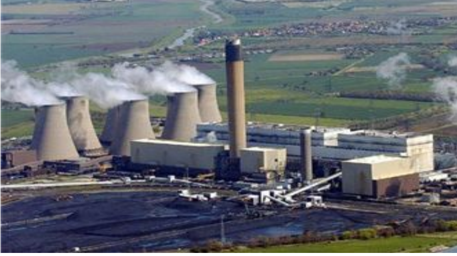
Şekil 2.2: Kömür enerji santrali [44]
