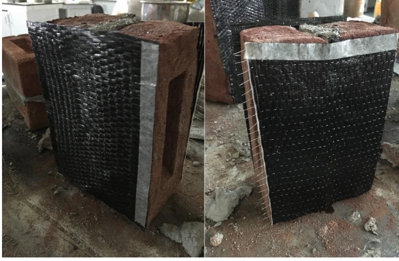
Resim 3.15. CFRP kumaşın yan yüzeylere epoksi reçineyle yapıştırılması
