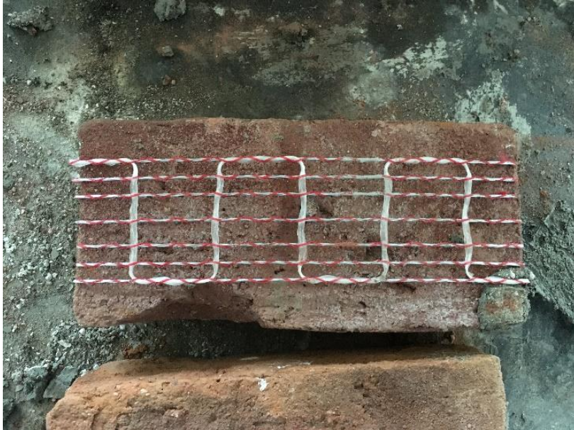
Resim 3.16. Yatay derz donatısının yerleştirilmesi
