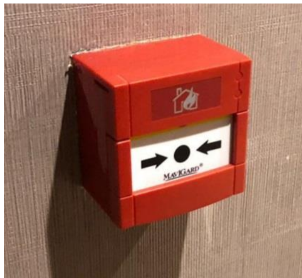
Resim 3.21. Manuel ihbar butonu
