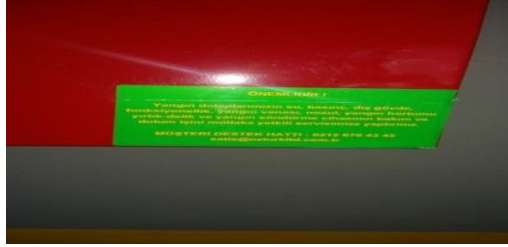
Resim 4.26. Uyarı iliştirilmiş yangın dolabı
