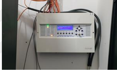
Resim 4.46. CC odasında yangın algılama paneli
