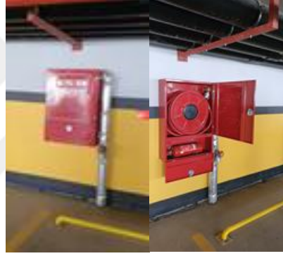
Resim 3.36. Yangın dolabı
