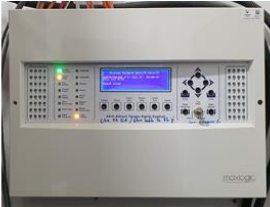
Resim 3.18. Adresli yangın alarm sistemleri (Url-6)
