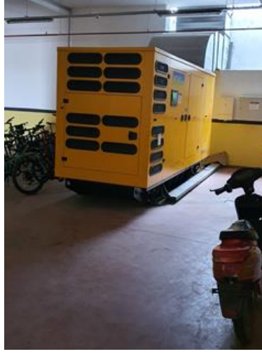
Resim 4.38. Kapalı alanda yaklaşma mesafesi sınırlanmamış jeneratörler görülmektedir Soldakinde havalandırma bulunmamaktadır, sağdaki resimde havalandırma mevcuttur. Fakat yangın söndürücülerini mevcut değildir.
