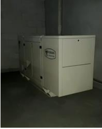
Resim 4.38. Kapalı alanda yaklaşma mesafesi sınırlanmamış jeneratörler görülmektedir Soldakinde havalandırma bulunmamaktadır, sağdaki resimde havalandırma mevcuttur. Fakat yangın söndürücülerini mevcut değildir.
