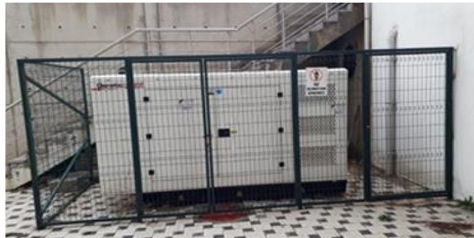
Resim 4.37. Açık alanda yaklaşma mesafesi yapılmış jeneratörler yangın söndürücüleri mevcut değil.
