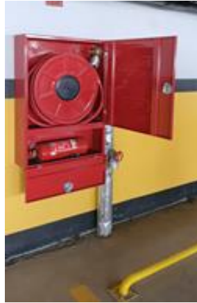
Resim 4.28. Uygun konumlandırılmış hortum ve vanası olan yangın dolabı
