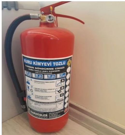
Resim 4.15. Yangın tüpü
