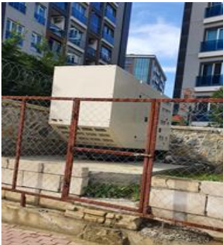
Resim 4.37. Açık alanda yaklaşma mesafesi yapılmış jeneratörler yangın söndürücüleri mevcut değil.
