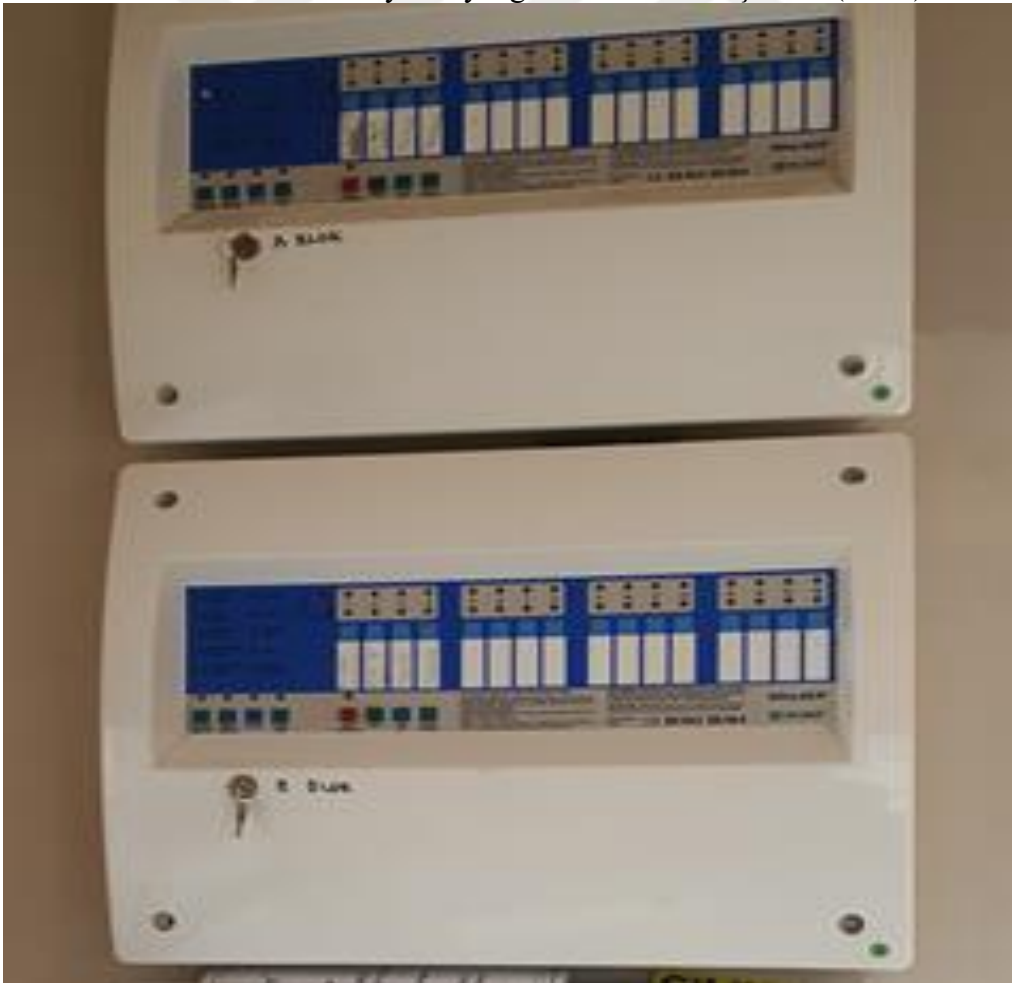
Resim 3.16. Konvansiyonel yangın alarm sistemi
