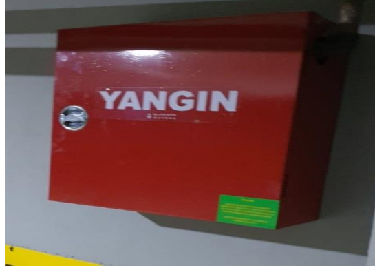
Resim 3.30. Yangın dolabı
