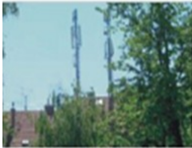
a-Cep telefonu baz istasyonu
